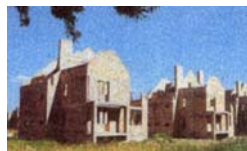
СУЧАСНЕ ЖИТЛОВЕ БУДІВНИЦТВО
